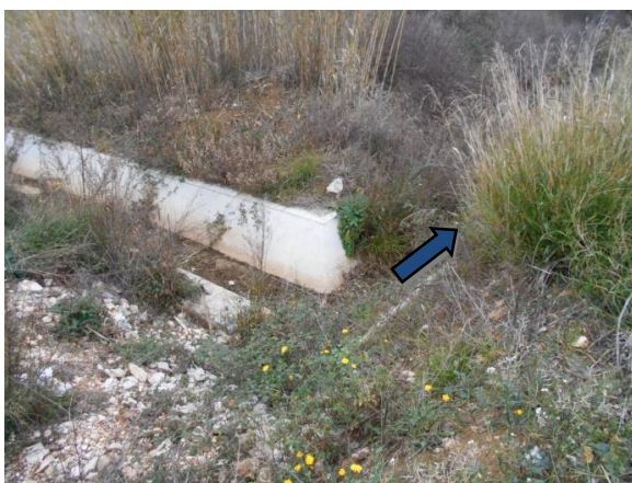
Exutoire vers le milieu naturel (fossé)
