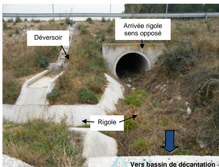
Photo illustrant le déversoir et l'arrivée des eaux récupérées par l'autre voie d'autoroute (Engéo, 2016)
