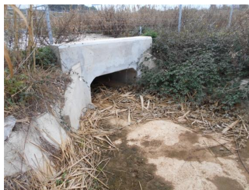
Sortie du bassin de décantation
