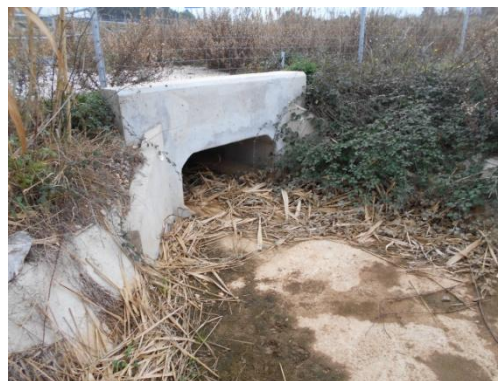
Sortie du bassin de décantation
